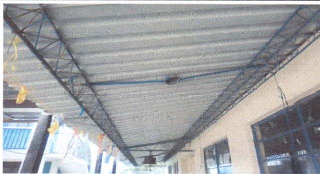
Foto 5: Sustitución de focos ahorradores
