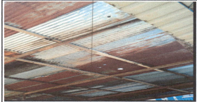
Foto 2: Sustitución de madera por metal
