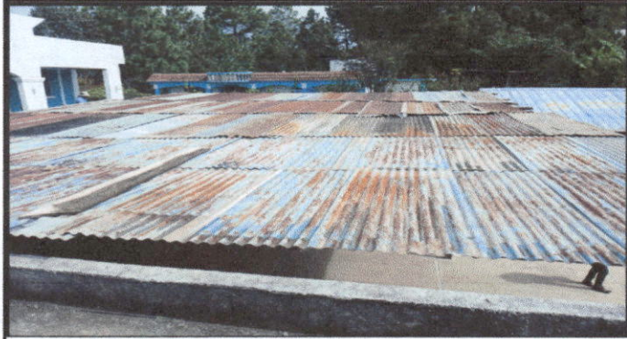
Foto 1: Sustitución de lámina por lámina troquelada aluzinc calibre 26
