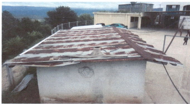
Foto 3: Sustitución de lámina por lámina troquelada aluzinc calibre 26 (cocina)
